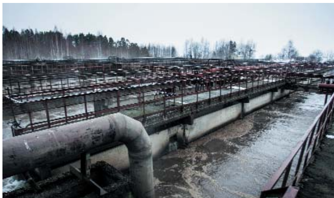
Азротенки до реконструкции
