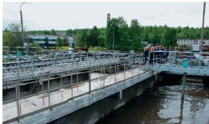
Азротенк после реконструкции
