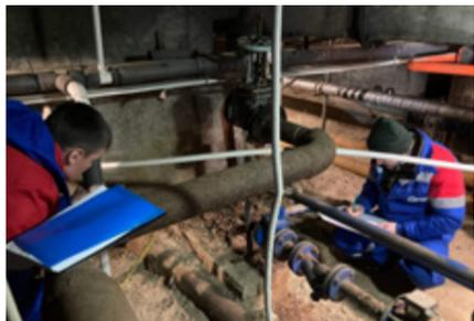
После анализа специалисты определяют, что уже подлежит замене, укажут, где находятся задвижки, повороты и наклоны, как трубы пересекаются с другими коммуникациями. На основе этих данных создадут план работ с учетом существующего состояния оборудования.
