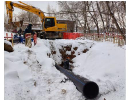
В прошедшем году компания «НОВОГОР-Прикамье» проделала масштабную работу по повышению надежности водоснабжения и водоотведения Перми. Выполнена перекладка более 22 км городских сетей водоснабжения и водоотведения.
